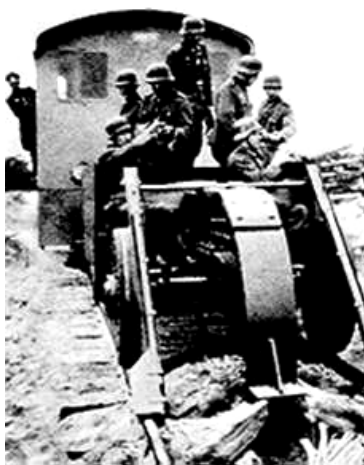
Trnokop tzv. «Schienenwolf» lomi željezničke pragove kao da su čačkalice.
